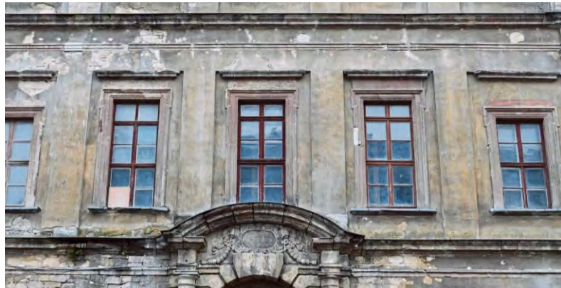
Seit Jahrzehnten steht der Südflügel von Schloss Neu-Augustusburg leer. Nach der Sanierung soll er nun Verwaltungssitz werden. FOTO: ALEXANDER KEMPE
